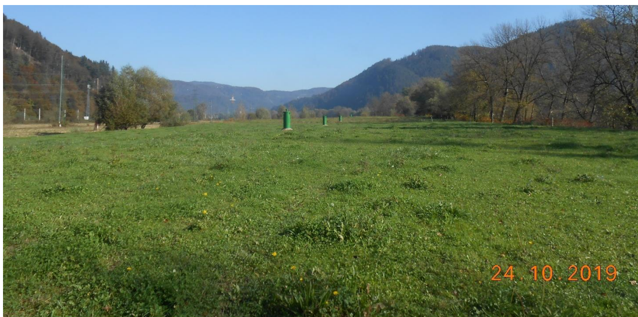
Zatravljeno območje odlagališča nenevarnih odpadkov Širjava s plinjaki opremljeni z BIO filtri
